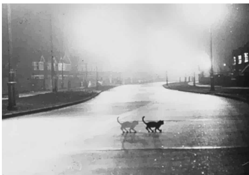
Figuur 1: Silhoueteffect van straatverlichting geïllustreerd. Een witte en een zwarte kat worden gezien als donkere silhouetten tegen het heldere wegdek van hoge luminantie (foto: Waldram 1938).
