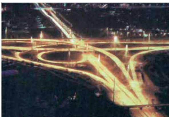
Figuur 3: Olympia knooppunt in München (1972): 650 hogedruk natrium schijnwerpers (250 en 400 W) op 23 masten van 35 m. Lichtrichting voornamelijk tegen de richting van het verkeer (counterbeam). Foto's: Philips.
