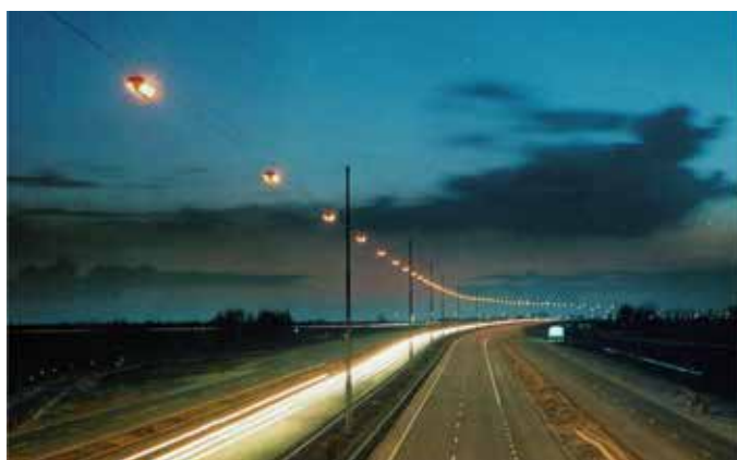
Figuur 1: Lijnverlichtingsinstallatie met tweelamps-armaturen op de A15 bij Gorinchem, geïnstalleerd in 1976 en verwijderd in 2006. Foto: Philips.
