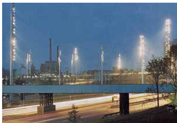
Figuur 3: Olympia knooppunt in München (1972): 650 hogedruk natrium schijnwerpers (250 en 400 W) op 23 masten van 35 m. Lichtrichting voornamelijk tegen de richting van het verkeer (counterbeam). Foto's: Philips.
