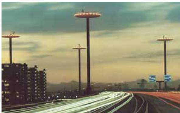
Figuur 2: IJsselmondeplein bij Rotterdam (1965). Zestien, inwendig met een trap toegankelijke stalen torens, in hoogte variërend van 26 tot 35 m, met elk 24 rotatie-symmetrisch gemonteerde 135 W lagedruk natrium schijnwerpers aan een 9 m diameter platform. Kosten per complete mast: 108.000 gulden. Pogingen om één mast als monument te behouden bij de reorganisatie in 1989 van het wegennetwerk waren niet succesvol. Foto: Philips.
