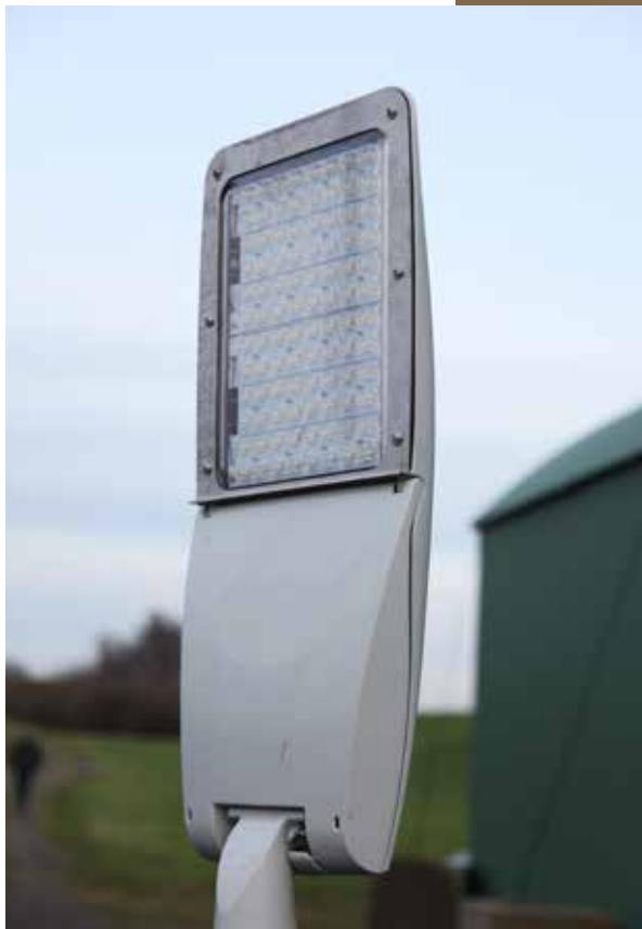
Figuur 2: foto's ter illustratie van een niet-uniforme armatuur in straatverlichting.
