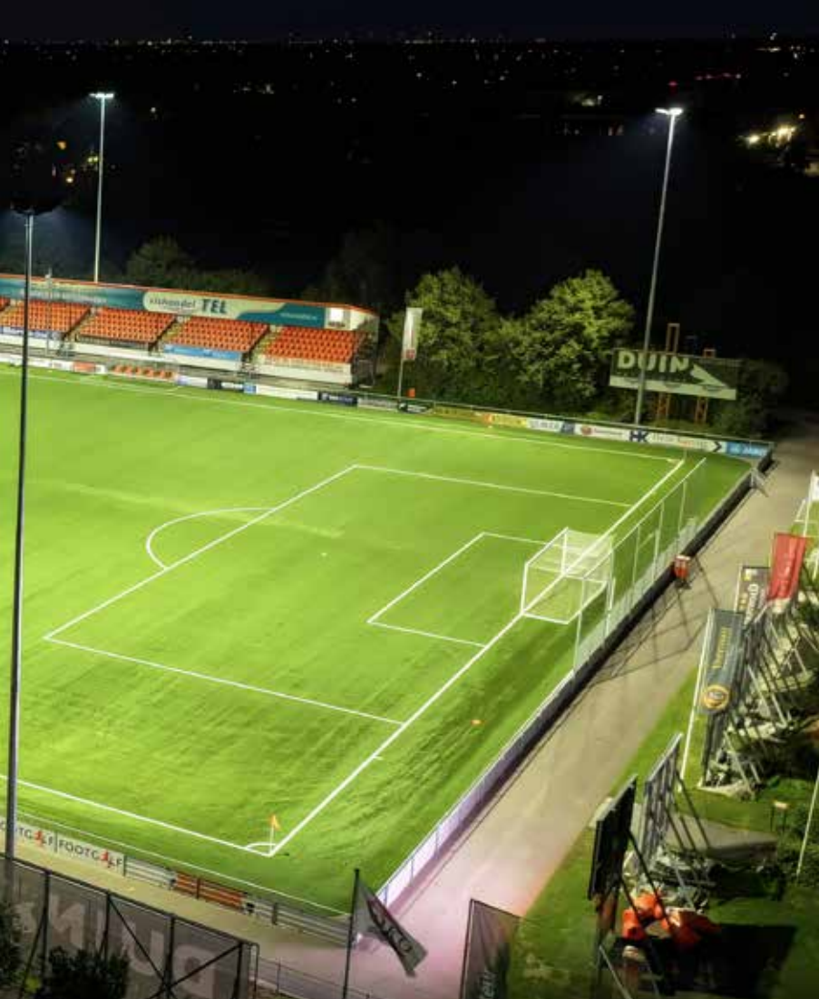
Foto (Copyright 2024 L. de Graaf): voorbeeld van een voetbalveld met 300 lux en masten van 22 meter.
